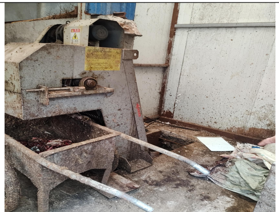
污水进水口、格栅
