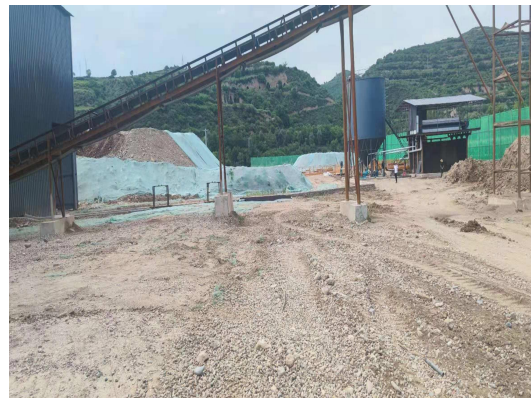
厂区沙化及围挡墙
