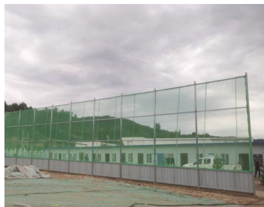
抑尘墙及办公区
