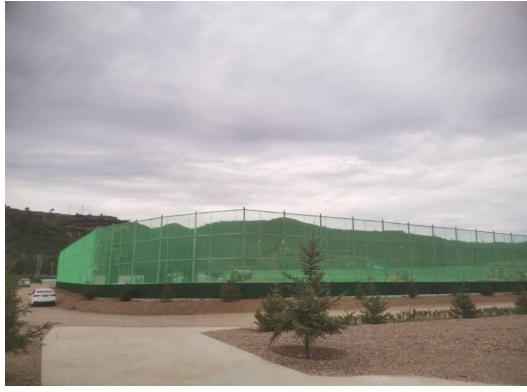
新增绿化、厂区围挡
