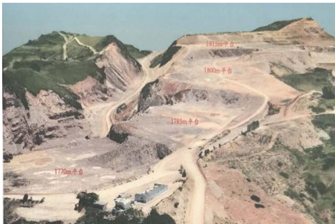
图 4-1 开采平台现场照片
