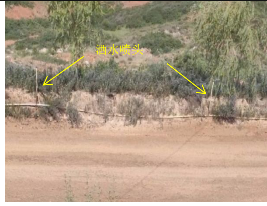
运输道路旁洒水设施
