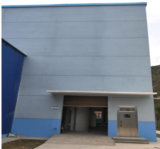
污泥脱水机房及转运棚
