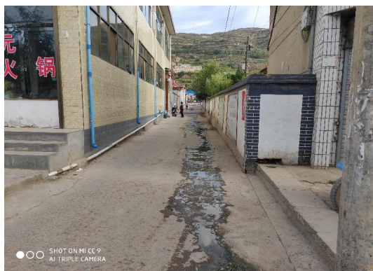
中心卫生院100m污水管道及路面恢复
