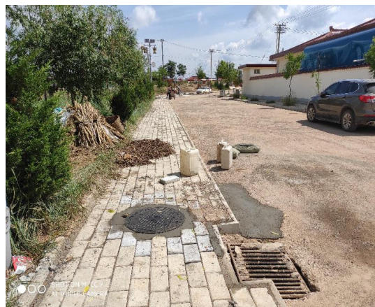
董湾新农村路面恢复
