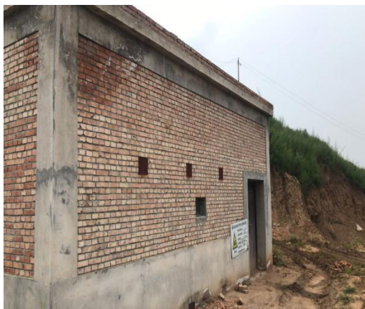
危险废物暂存间（外观）
