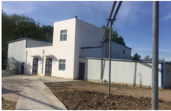
工业废污水处理站
