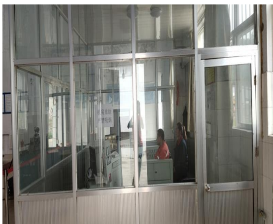
混合井提升机房隔声操作间
