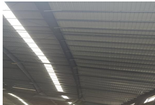
煤棚内部结构（大跨度网壳）
