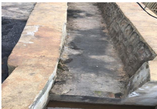
煤棚排水（雨水）
