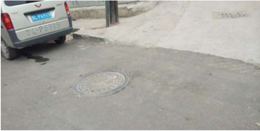
路面恢复（南山公园西侧公厕污水管网）
