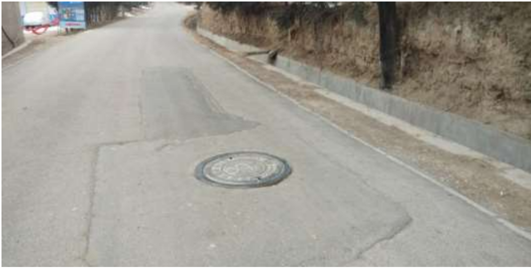
路面恢复（南环路至南山公园顶）
