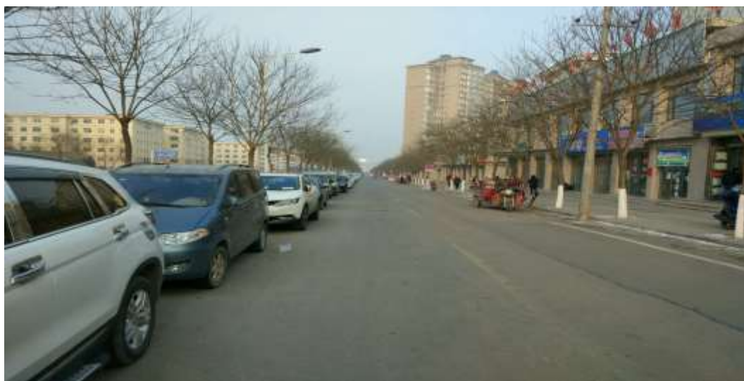
路面恢复（甘沟河段）
