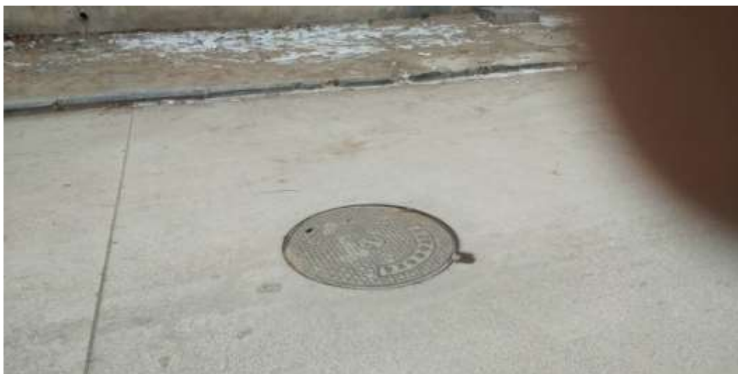
路面恢复（天馨路至玄鹤路段）
