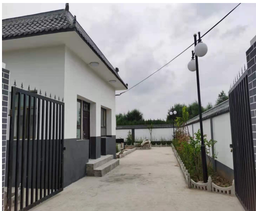
地埋式污水处理区
